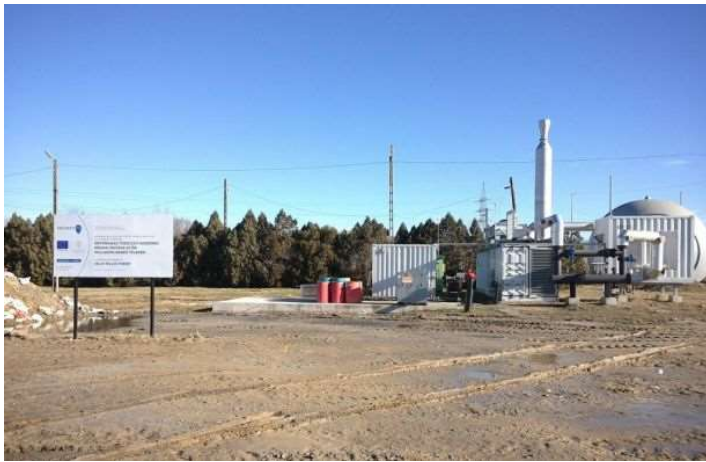
7. ábra: A depóniagáz tüzelésű kiserőmű a lezárt győri hulladéklerakó telepen (Forrás: http://www.arrabonadepo.hu )
