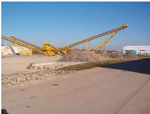
21. ábra: Építési hulladékot törő-válogató berendezés Szegeden (Forrás: SZKHT honlap)
